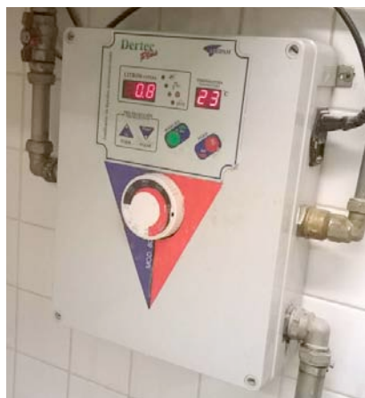
Figura 2.9 - Equipamento para refrigerar a água do preparo das massas (Autor, 2015)
